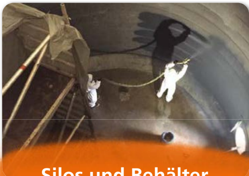
Silos und Behälter
