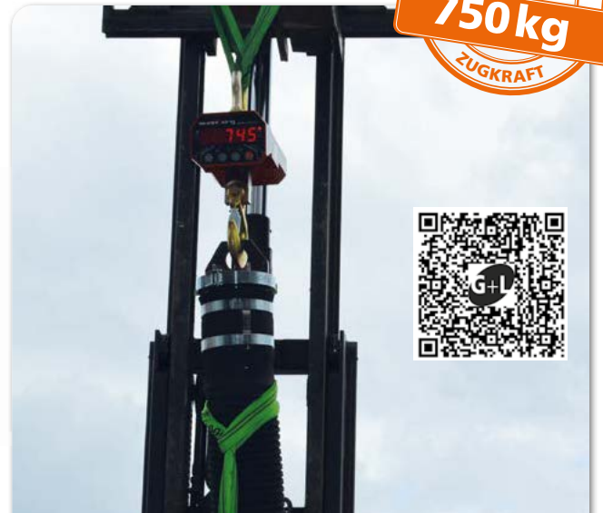
Im Eigenversuch getestet, hielt die Verpressung einer Zugkraft von mindestens 750 kg stand!
